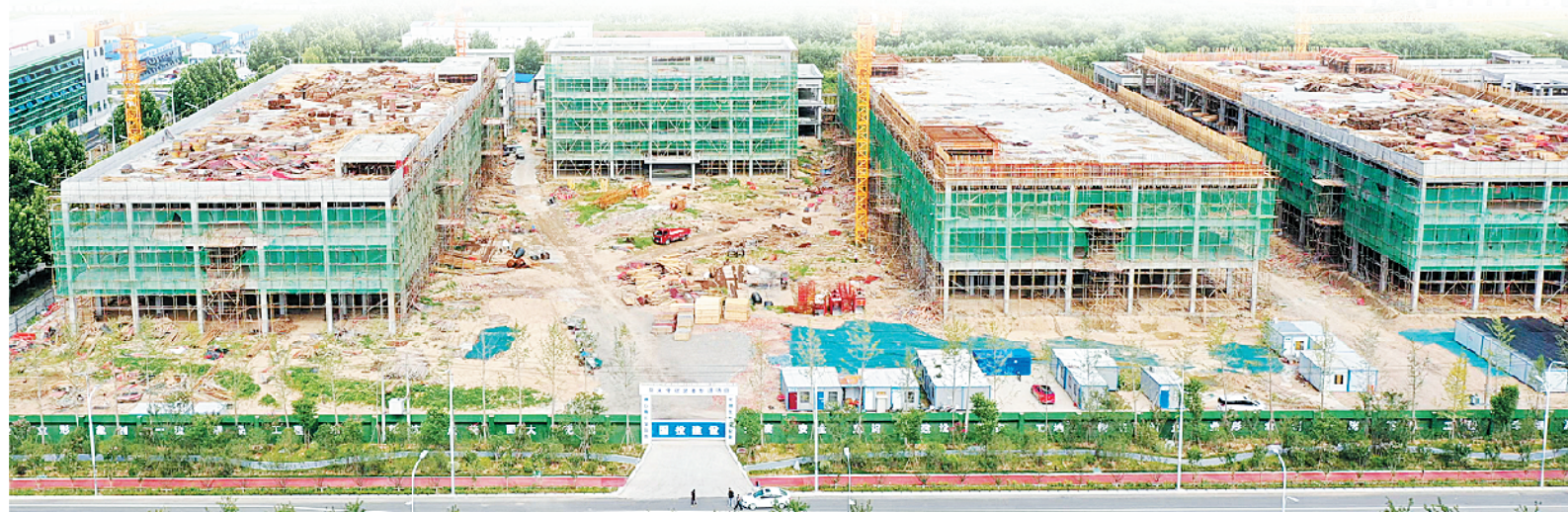
一直以来,沈丘县委、县政府认真贯彻落实市委、市政府有关要求,坚持“工业强县、产业兴县”战略,聚焦钢铁、食品、电磁新材料产业,大力实施“1+10+2”工程,实行园区化管理、集聚式发展,滚动推进“三个一批”项目开工建设。图为总投资10亿元的泰燃科技项目建设现场。
