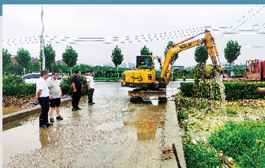
7月16日,周口临港开发区对辖区沟渠河道堵点进行清理,确保城区排水畅通。 记者 宋风摄
