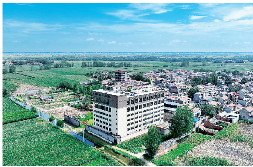
大史行政村村口的电气公司综合楼即将启用。
