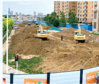
滨河南路大庆路东生态停车场正在施工中
