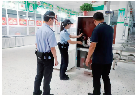
民警检查学校的消防设施。
